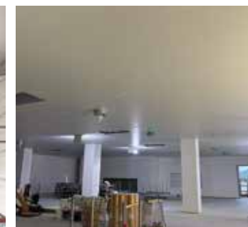
▲ 施工実績②
